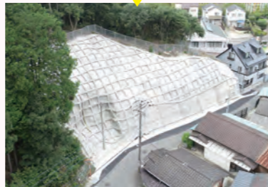
▲原田下のり面補強
