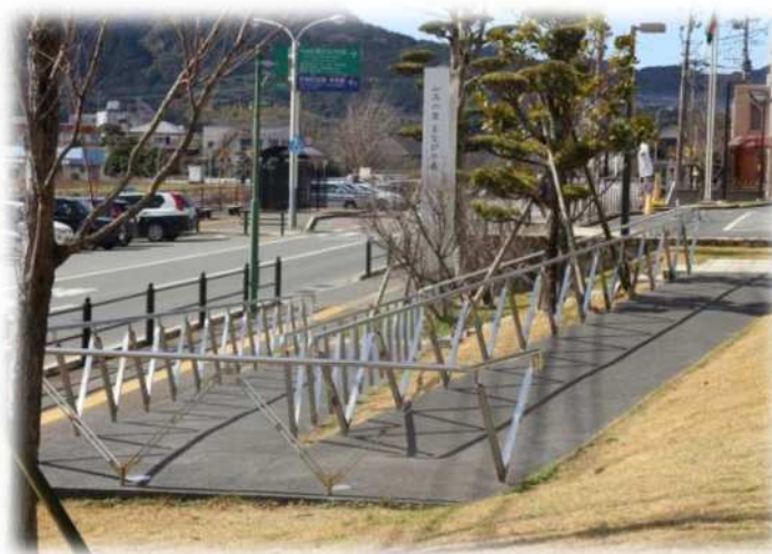
■図書館前スロープ
