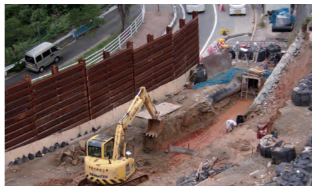
▲ひばりが丘法面災害復旧工事の様子
