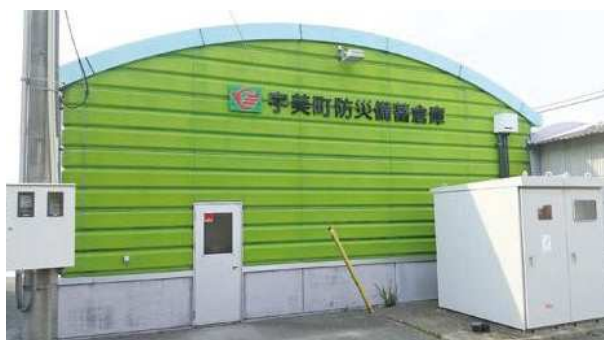
最終処分場内に設置
