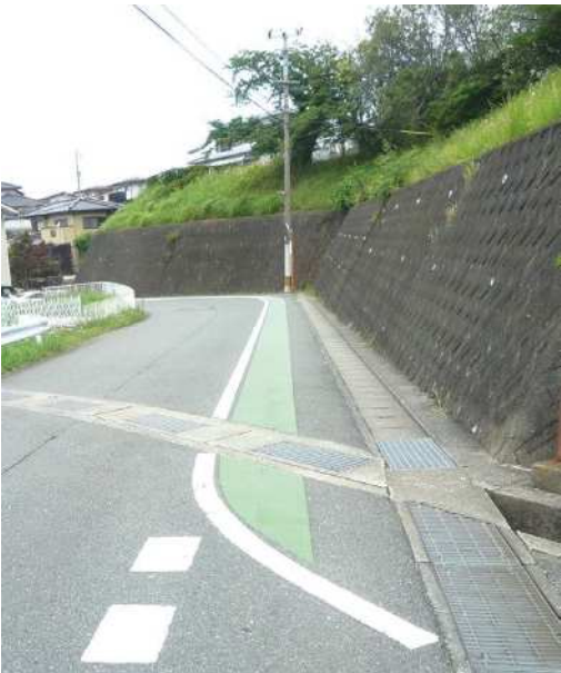
グリーンベルトの設置状況
