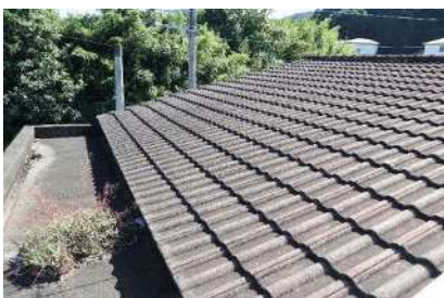
屋根材の劣化・一部破損
