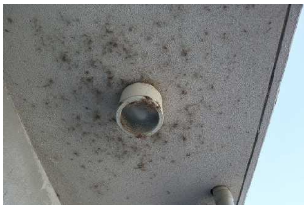
共用部廊下の照明器具
