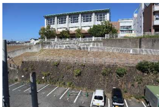
2棟北側の隣接地（宇美南中学校）
