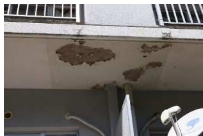
バルコニー天井裏の塗装剥離
