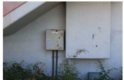
屋外設備ボックスの塗装劣化・錆
