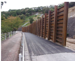
町道竹ヶ下～桜ヶ丘線の復旧の様子
