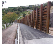
町道竹ヶ下～桜ヶ丘線の復旧の様子
