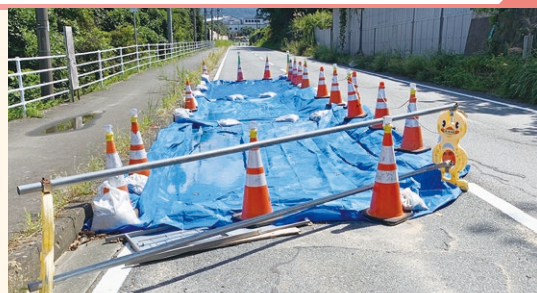
陥没した道路
