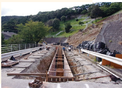
10月1日時点の基礎工事
