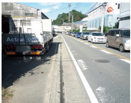
危険な歩道の様子(町道 長谷～松ヶ本線)
