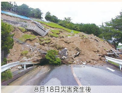
8月18日災害発生後
