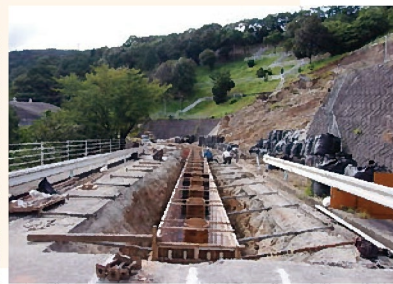
10月1日時点の基礎工事
