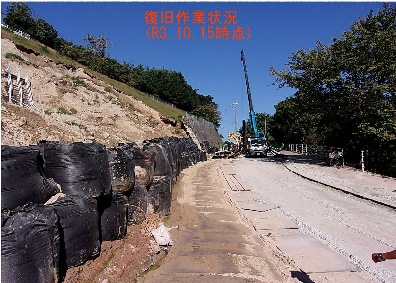
復旧作業状況 (R3. 10. 15時点)
