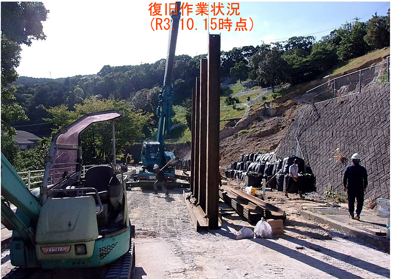
復旧作業状況 (R3.10.15時点)
