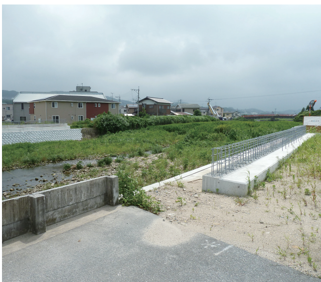
光正寺から見た橋台
