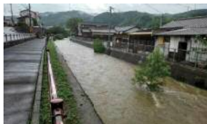
増水した井野川 (貴船1丁目菱縮橋付近)
