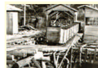
〔トロッコ〕 とれた石炭は、斜坑からトロッコを使って選炭場に運ばれました。
