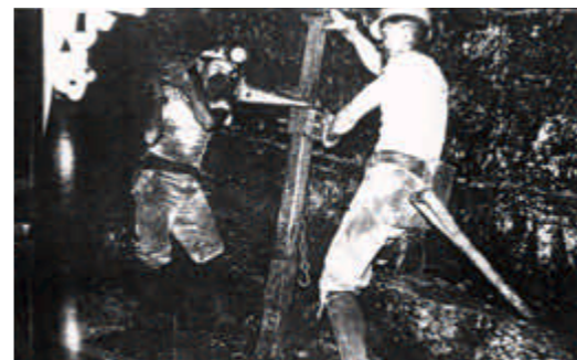
落盤防止のために支柱をたてる鉱員
