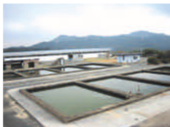
山の内浄水場
