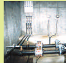
流量調整弁 (水の量を調整します)
