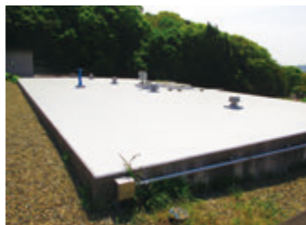
柳原浄水場・配水場
