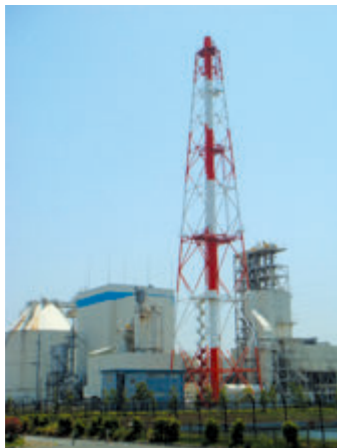
大牟田リサイクル発電所
