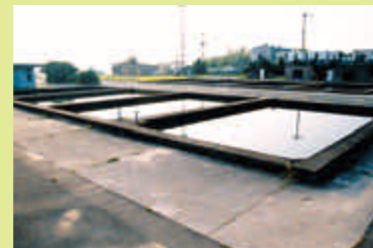
緩速ろ過池 (こまかいごみ・ほこりをろ過します)
