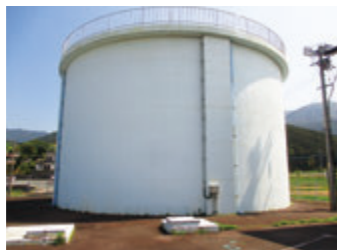
障子岳浄水場
