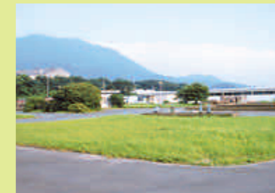
配水池 (水を地下にためておきます)
