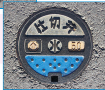
仕切弁 水道管の水の流れを止める弁
