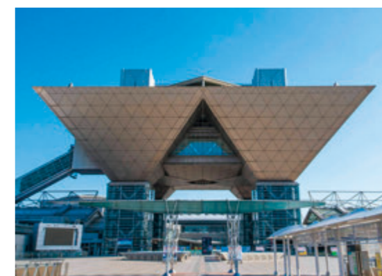
東京ビッグサイト (熱源空調工事)
