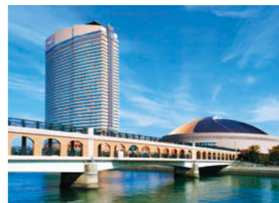
ふれあい橋 (高欄工事)
