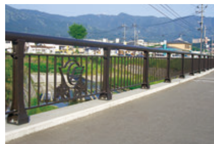
正法橋 (高欄工事)
