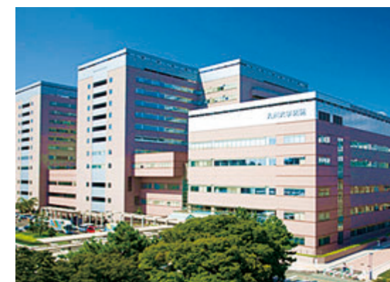
九州大学病院 (熱源空調工事)
