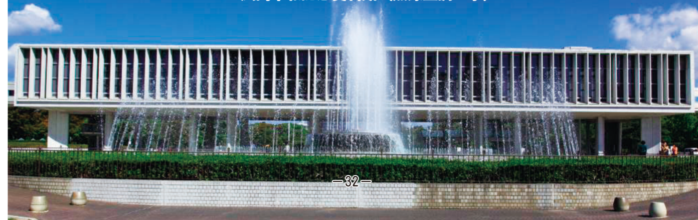
広島平和記念資料館 (熱源空調工事)
