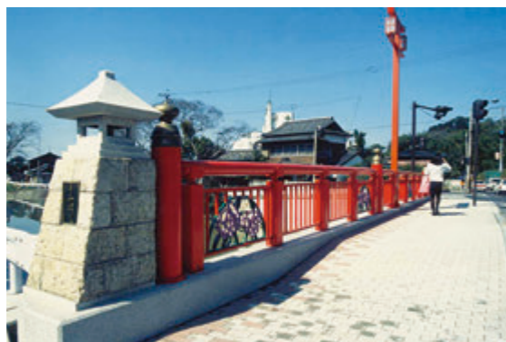
宇美橋 (高欄工事)
