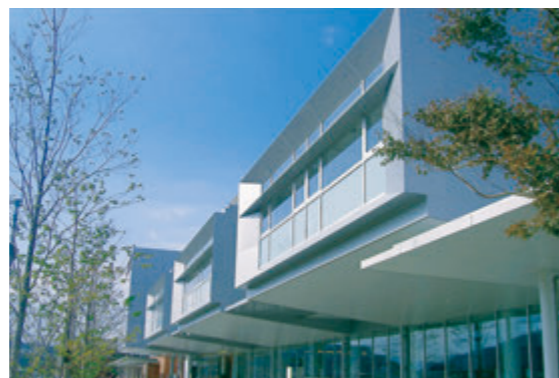
宇美町地域交流センターうみ・みらい館 (建築金物工事)
