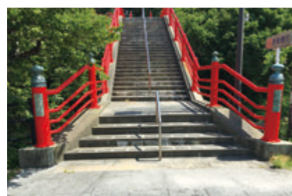
子安新橋 (高欄工事)
