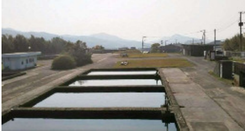
山の内浄水場
