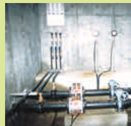
流量調整弁 (水の量を)
