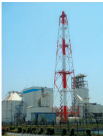
大牟田リサイクル発電所
