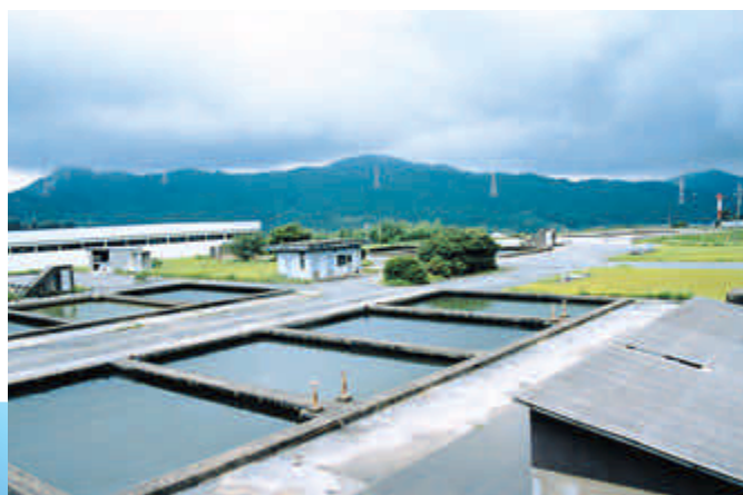
山の内浄水場の施設
