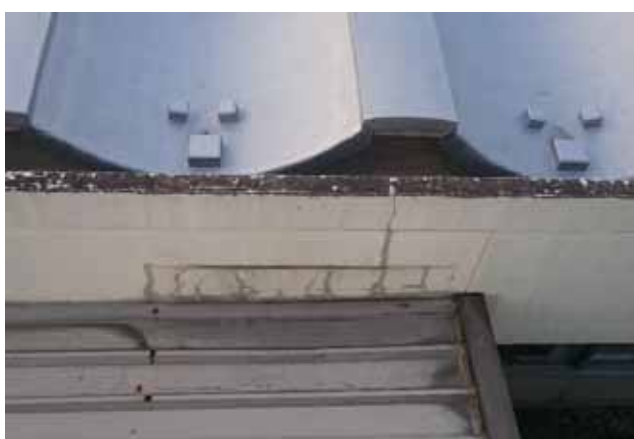
外壁のひび割れ
