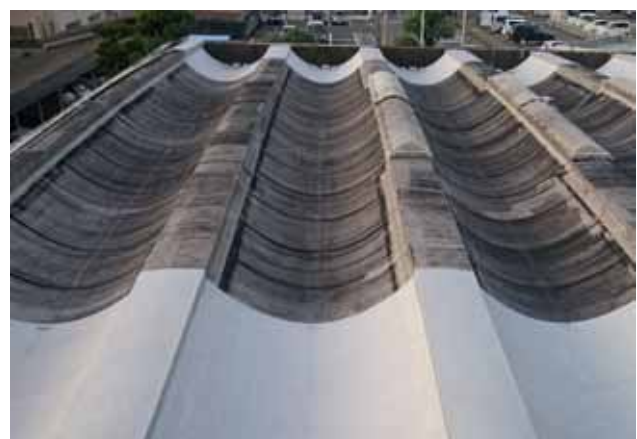
防水改修が不十分な屋上
