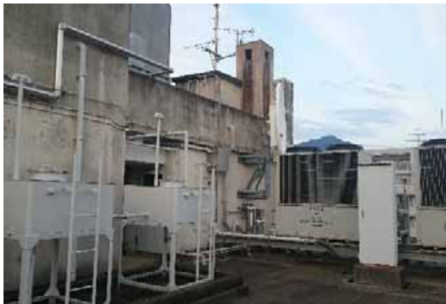
屋上の老朽化の状況
