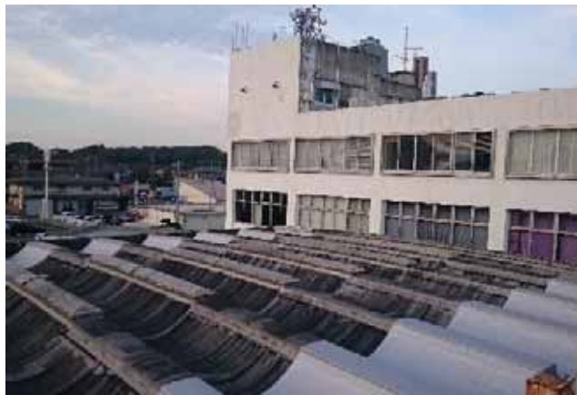
屋根の一部改修状況
