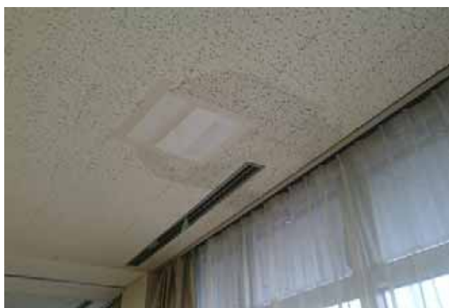
天井の雨漏り跡
