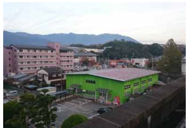
増築された南別館
