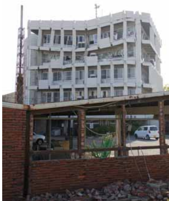
熊本地震で被災した宇土市役所 (写真：宇土市 HP より)
