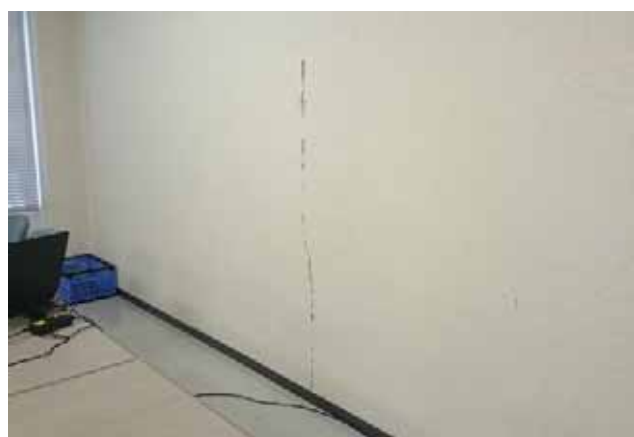
内壁のひび割れ
