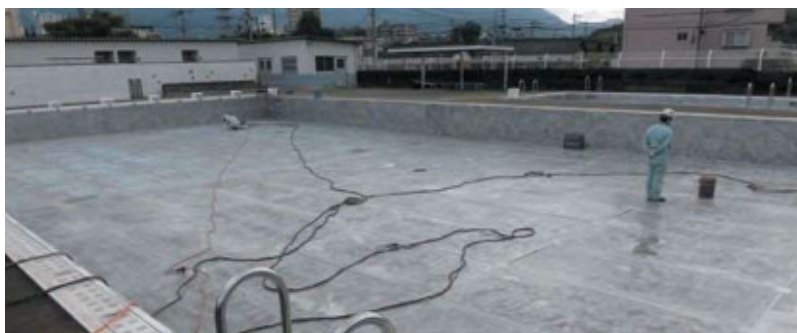
大規模修繕中の宇美小学校プール
