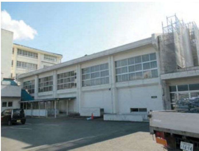
改修中の井野小学校体育館
