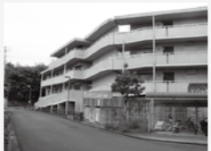
町営住宅外観
