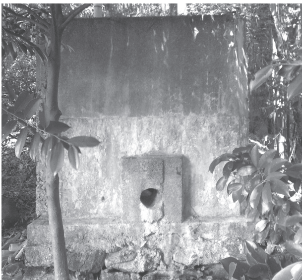
仲ノ原地区の小水力発電の貯水タンク
