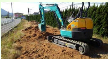
5/8 表土持込、重機で均し
