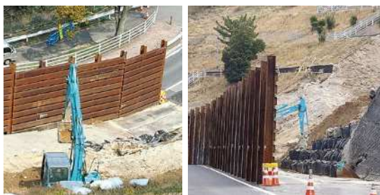
ひばりが丘の土砂崩れ
