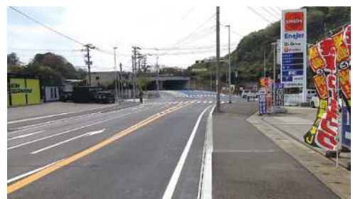
整備が完了した宇美西口交差点
